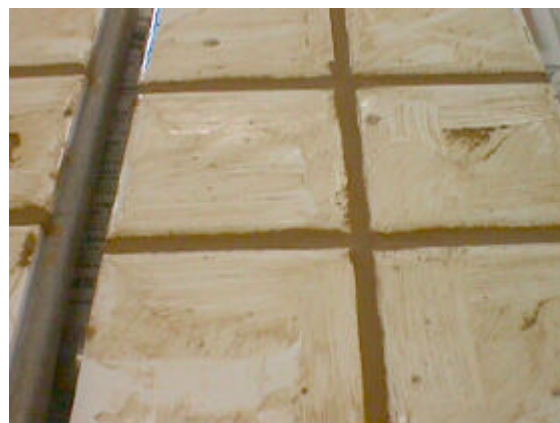
Figura 2: Limpeza grosseira das placas
