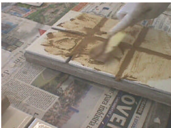
Figura 1: Aplicação do rejuntamento
