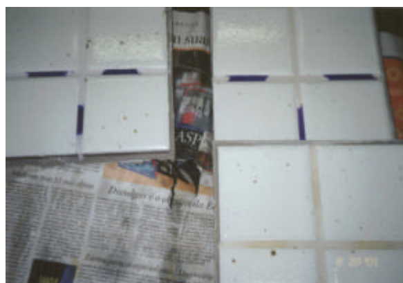
Figura 7 – Aspecto final da limpeza
